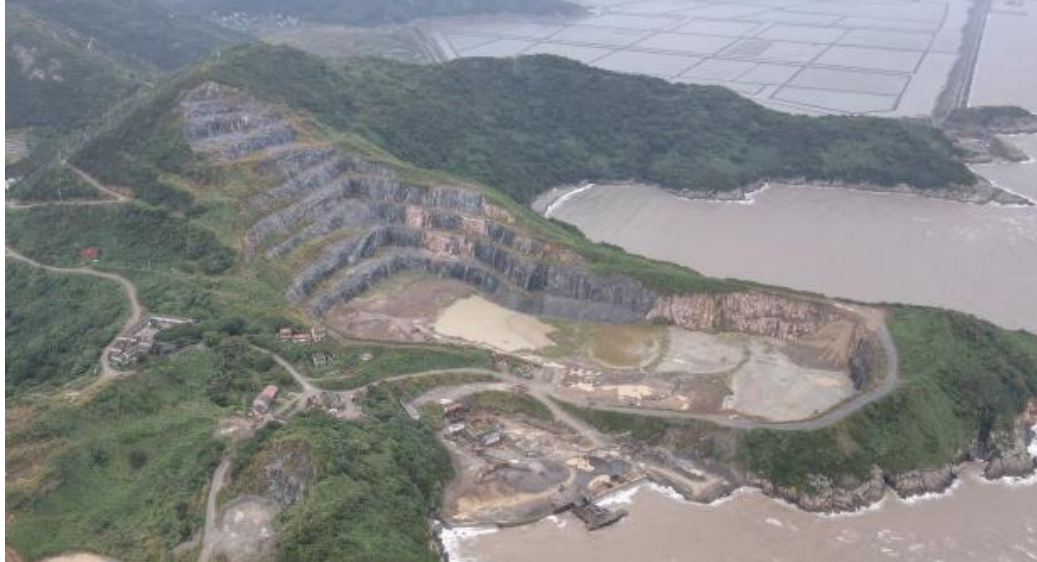
专项图1-3 治理区现状边坡及底盘概貌
