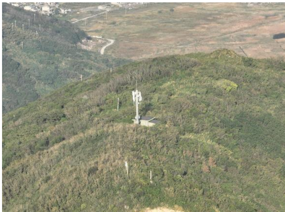
图2-6 北侧山顶通讯塔及基站
